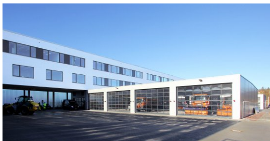
Neuer Betriebshof (Ansicht Hofseite), Pforzheim
