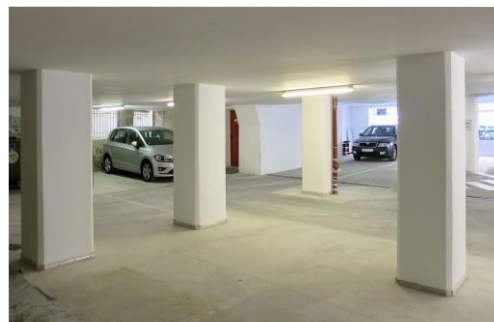
Tiefgaragenstützen nach der Sanierung
