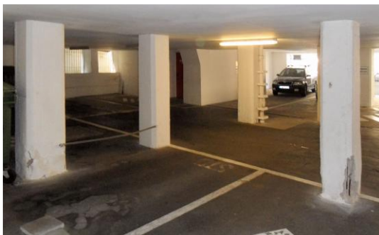
Tiefgaragenstützen vor der Sanierung
