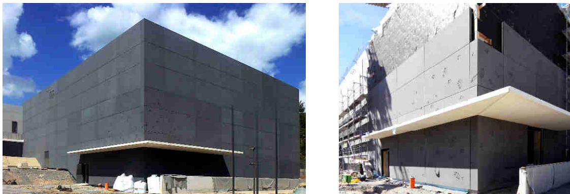
Abb. 5: Neubau einer Sporthalle mit vorgehängten Fassadenplatten aus Stahlbeton
