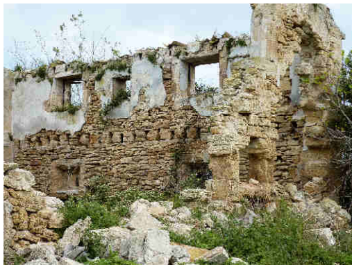
Abb. 1: links Natursteinmauerwerk und rechts vorgemauerte Fassade
