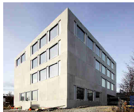
Abb. 3: Neubau Hochschulgebäude mit tragender Sandwichfassade aus Stahlbeton
